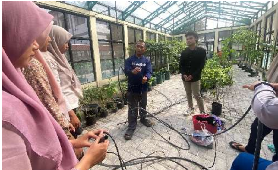
Gambar 3. Implementasi Pemasangan Irigasi Tetes
